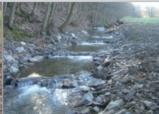
Wiederhergestellte Durchgängigkeit des Vinxtbachs, um den Aufstieg in andere Gewässerabschnitte für Wanderfische und andere Wasserorganismen zu ermöglichen.
